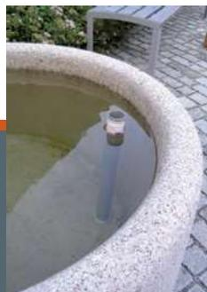
Wasser läuft über Standrohr ab
