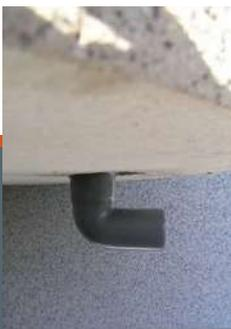
Anschlußmöglichkeit eines 50 mm HT-Rohr
