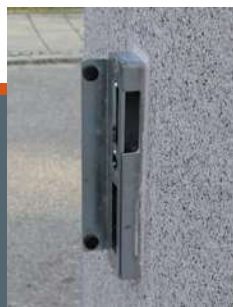
Elektrischer Türschließer in Säule einbetoniert
