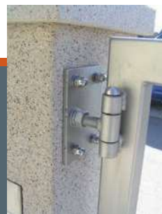
Türangeln, werden bauseits gedübelt
