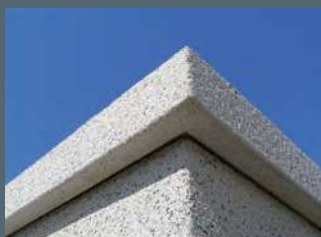
Abdeckplatten mit Einstand – kein eindringendes Wasser möglich
