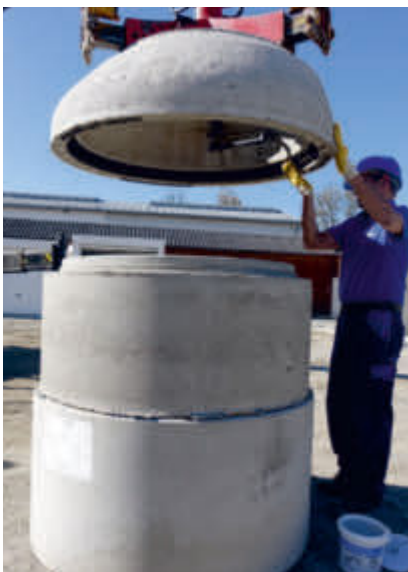
IDLA-Schachthals mit Gleitmittel versehen.....
