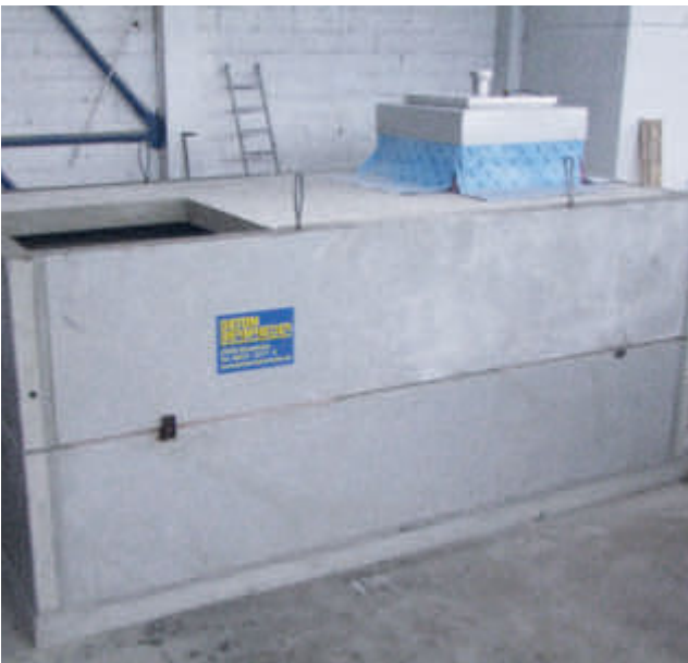
Brunnenschacht Kleinhöhenrain in Feldkirchen-Westerham mit aufgesetztem Technikraum
