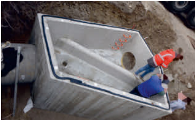
Trennbauwerk in Miesbach
