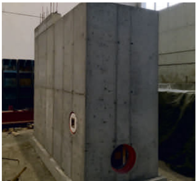
Maßanfertigung mit einer Systemschalung in druckwasserdichter Ausführung
