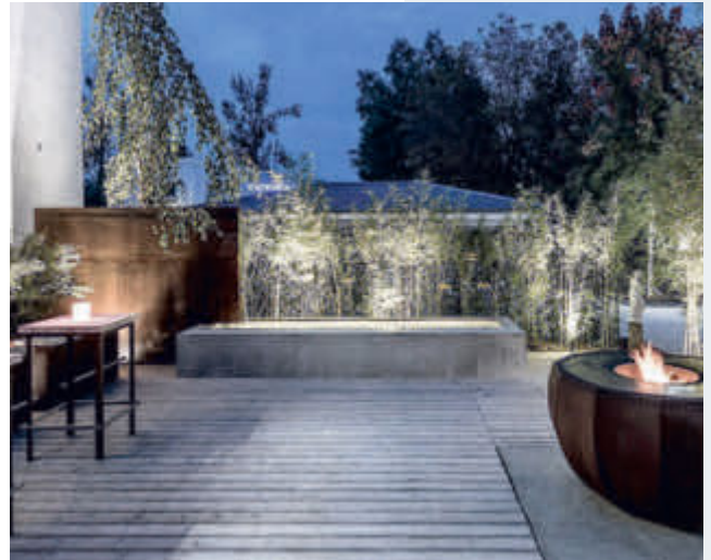
Wasserbecken in Sichtbeton
