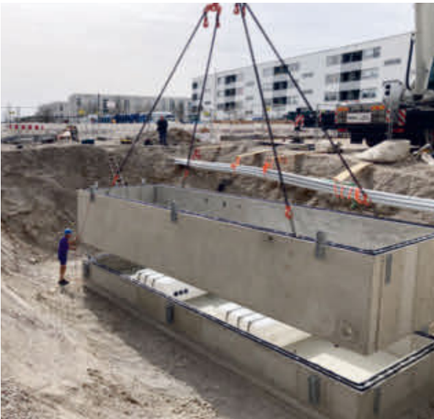
Brunnenstube in München-Riem, lichte Abmessungen L x B x H = 950 x 270 x 300 cm
