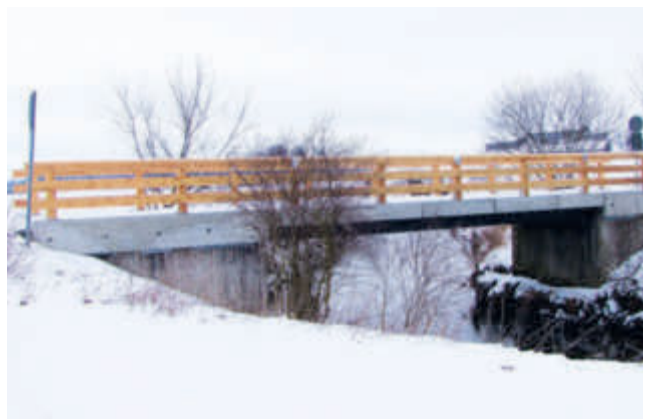
83043 Bad Aibling, Glonnbrücke bei Holzhausen
