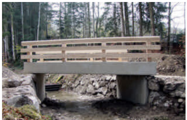
Spannweite 437 cm, Fahrbahnbreite 300 cm, Kreuzungswinkel Bach / Straße 66°
