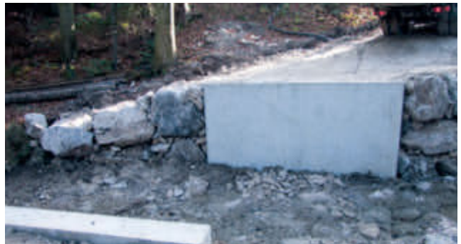
Hinterfüllung der Widerlager, Bachausbau
