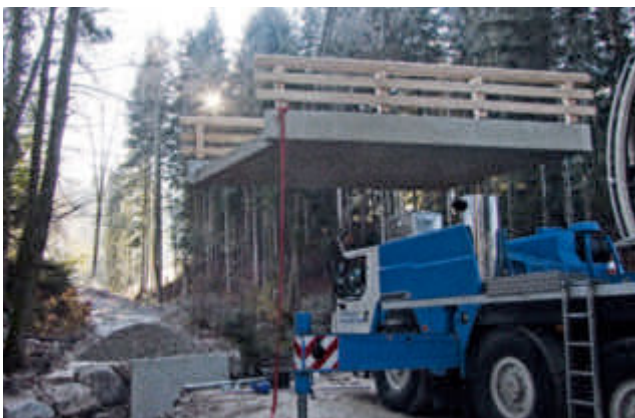
Versetzen der einteiligen Brückenplatte
