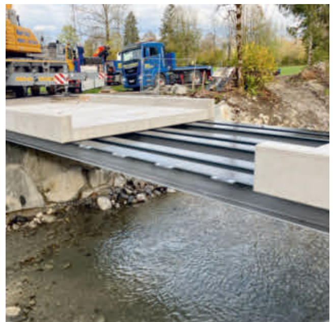
mit beidseitigem Schrammbord und Besenstrich
