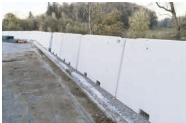
Stellwände Grundteile mit 2 Stapleraussparungen 20/10 cm
