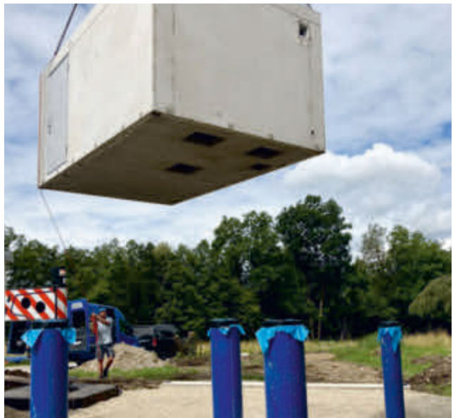
Betonfertigteiltbauwerk für die Wasserversorgung
