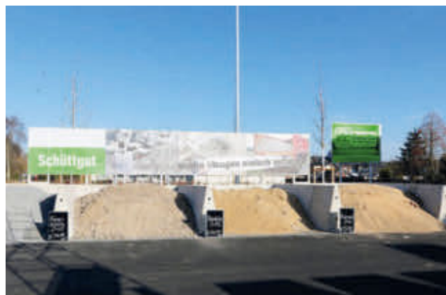
Schüttgutboxen mit aufgeschraubten Tafeln für Werbung oder Materialbezeichnung.
