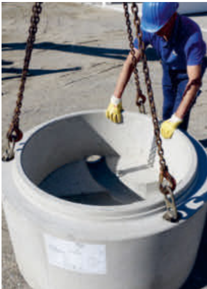
Schachtunterteil setzen.....
