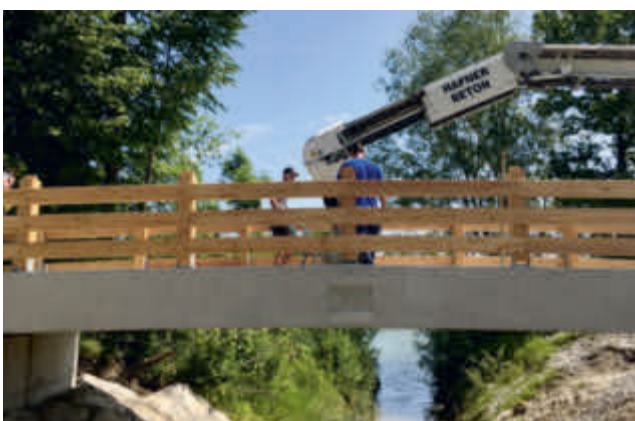
Brückenplatte mit Überhöhung, Jahreszahl
