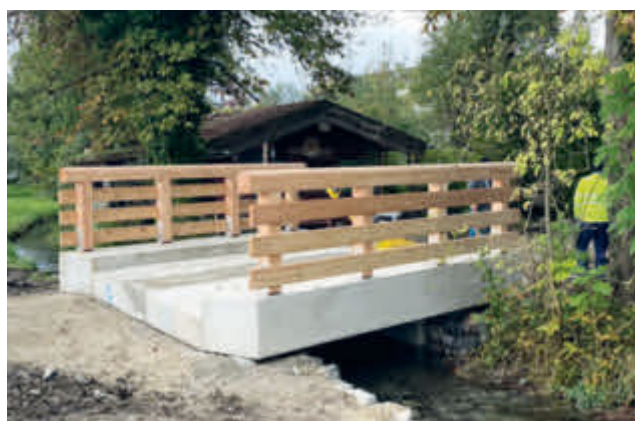
kurze Bauzeit durch Vorfertigung
