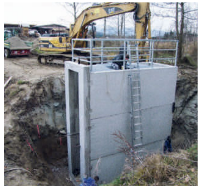
Brunnenschacht Kleinhöhenrain in Feldkirchen-Westerham mit aufgesetztem Technikraum
