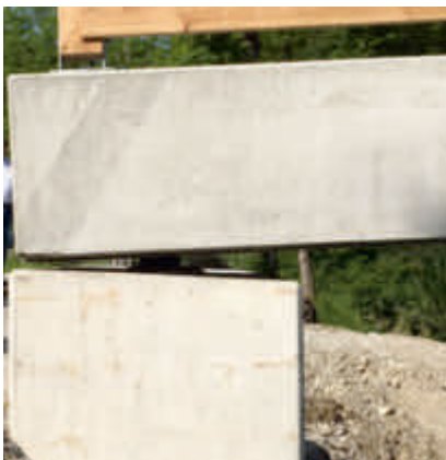
...auf Fundamente mit Brückenlager
