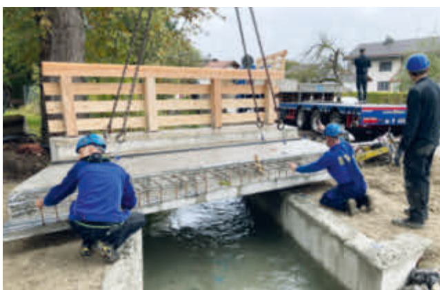
Versetzung auf Mörtelbett für Lastausgleich
