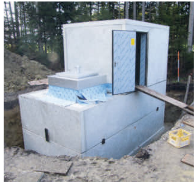
Brunnenschacht Kleinhöhenrain in Feldkirchen-Westerham mit aufgesetztem Technikraum
