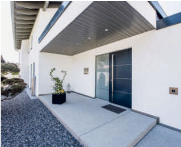
Eingangsbereich mit großen Betonplatten gestraht
