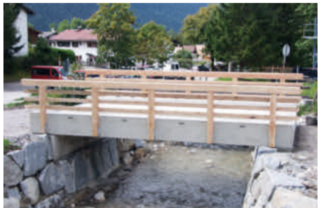
82487 Oberammergau/Brücke über die Große Laine
