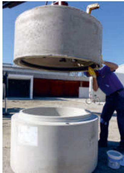
IDLA-Schachtring mit Gleitmittel versehen.....
