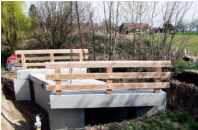
Spannweite 192 cm, Fahrbahnbreite 350 cm
