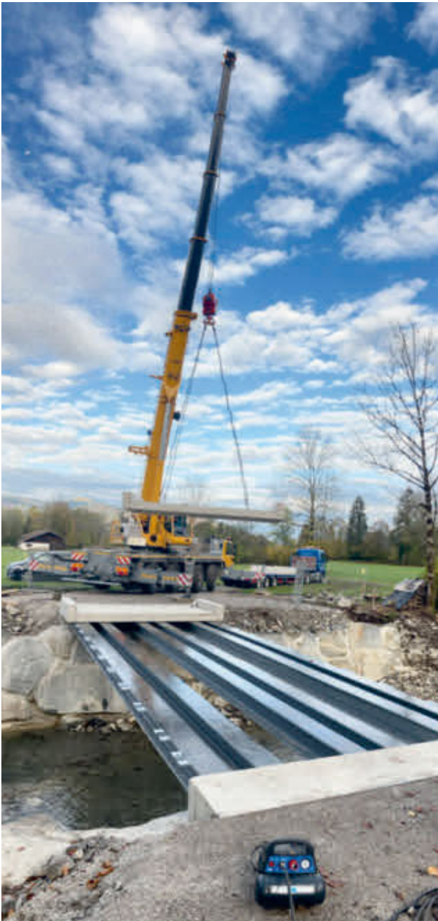
Oberbau aus 6 Fertigteilelementen
