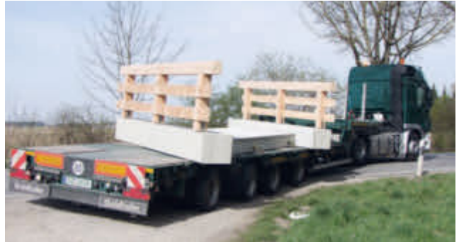
Anlieferung der kompletten Brückenplatte
