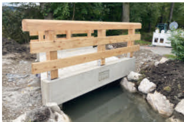
fertig montiertes Geländer in Balkenschuhen
