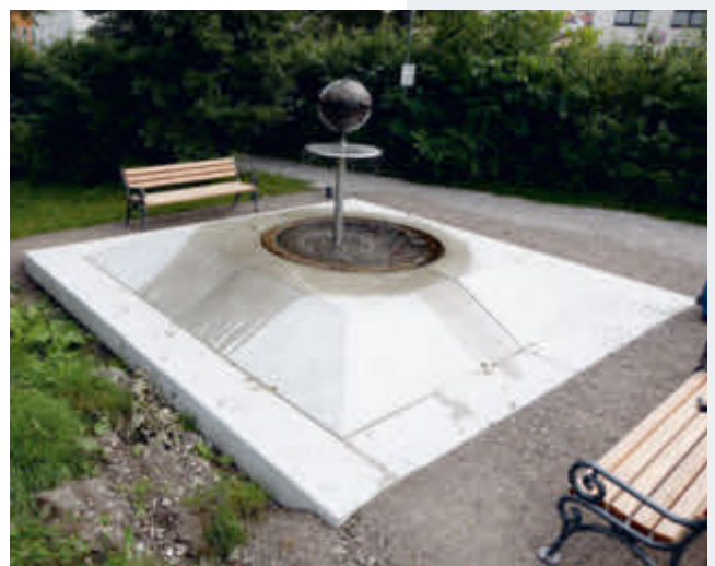
Brunnen in Sichtbeton
