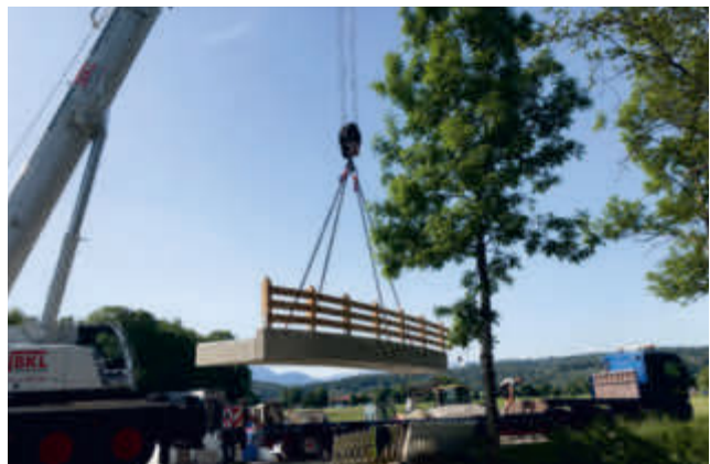
Versetzung mit dem Autokran...
