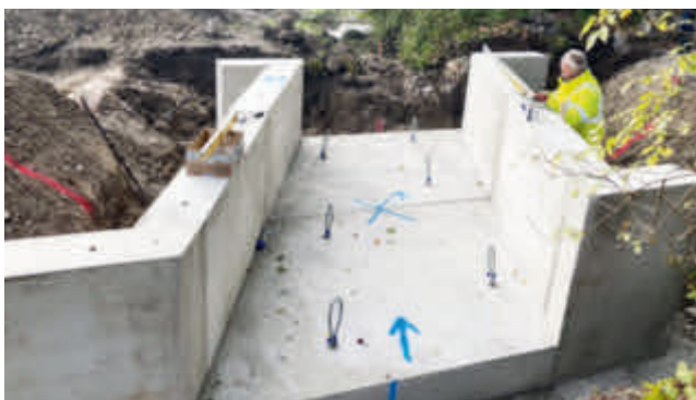
Unterbau in Rinnenausführung
