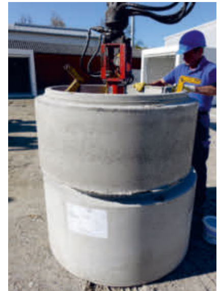
Ring aufsetzen.... (auf vertikale Anordnung der Lastübertragungselemente achten!)
