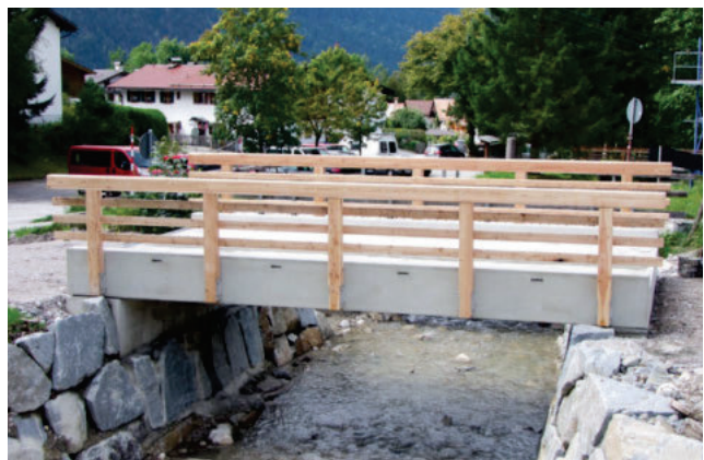
82487 Oberammergau/Brücke über die Große Laine
