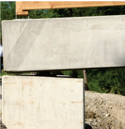
...auf Fundamente mit Brückenlager
