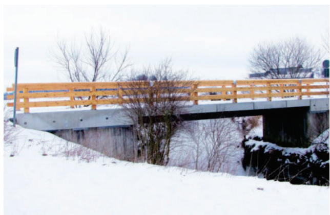
83043 Bad Aibling, Glonnbrücke bei Holzhausen
