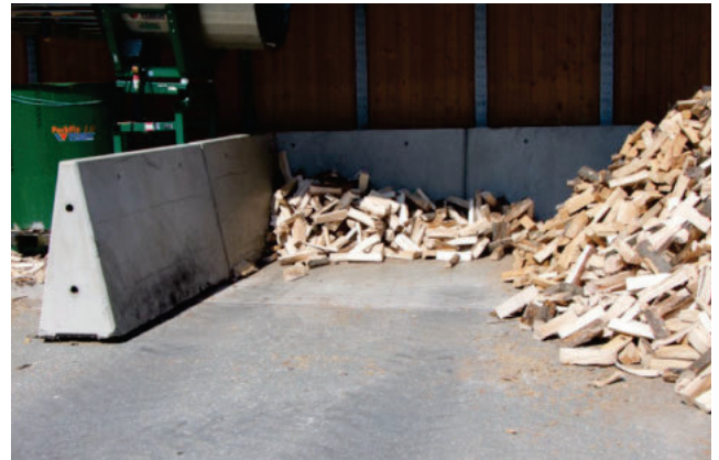
Trennwände zur Lagerung von Holzscheiten
