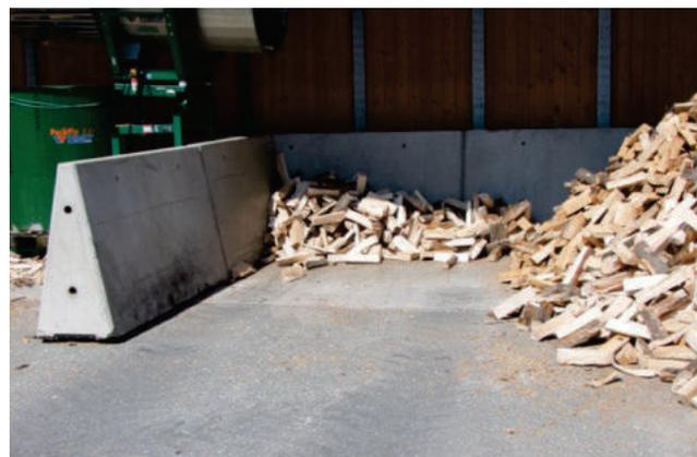
Trennwände zur Lagerung von Holzschneiten
