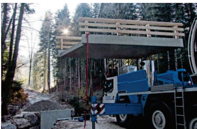
*Versetzen der einteiligen Brückenplatte*
