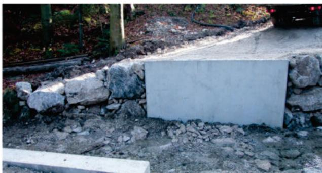
*Hinterfüllung der Widerlager, Bachausbau*
