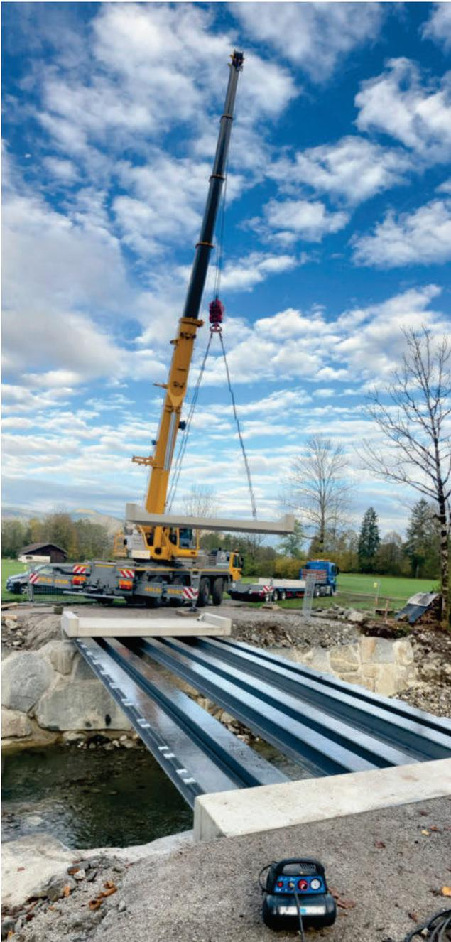
*Oberbau aus 6 Fertigteillementen*
