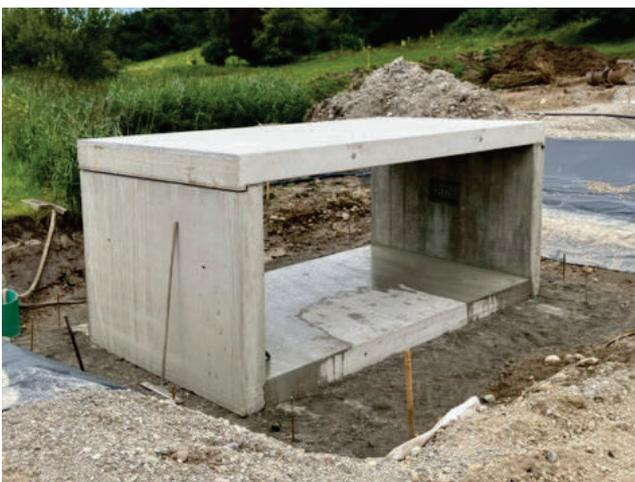
*Länge 5,60 m, Breite 3 m, mit Falzausbildung im Auflager und gestrahlter Oberfläche*
