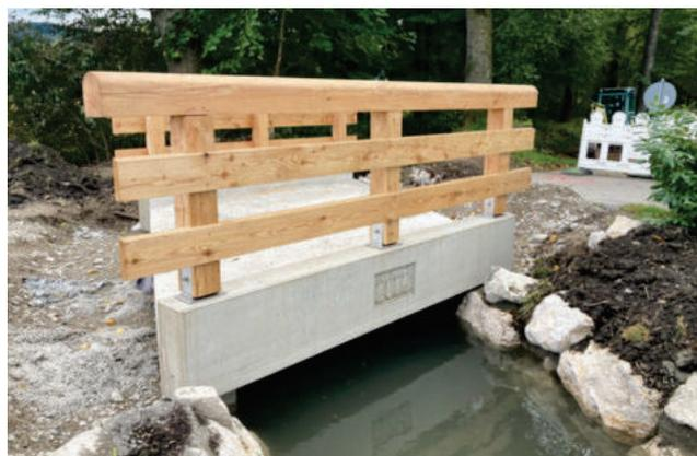
fertig montiertes Geländer in Balkenschuhen
