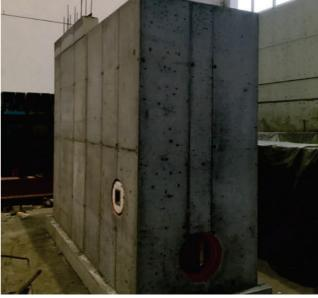
Maßanfertigung mit einer Systemschalung in druckwasserdichter Ausführung
