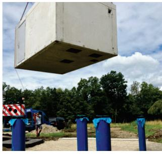
Betonfertigteilbauwerk für die Wasserversorgung
